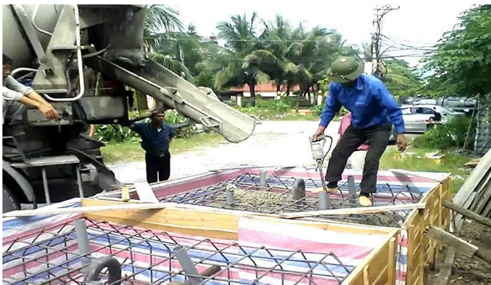
Công nhân Công ty đang triển khai đúc rùa Bê tông cốt thép loại 20 tấn phục vụ neo giữ phao tránh bão
