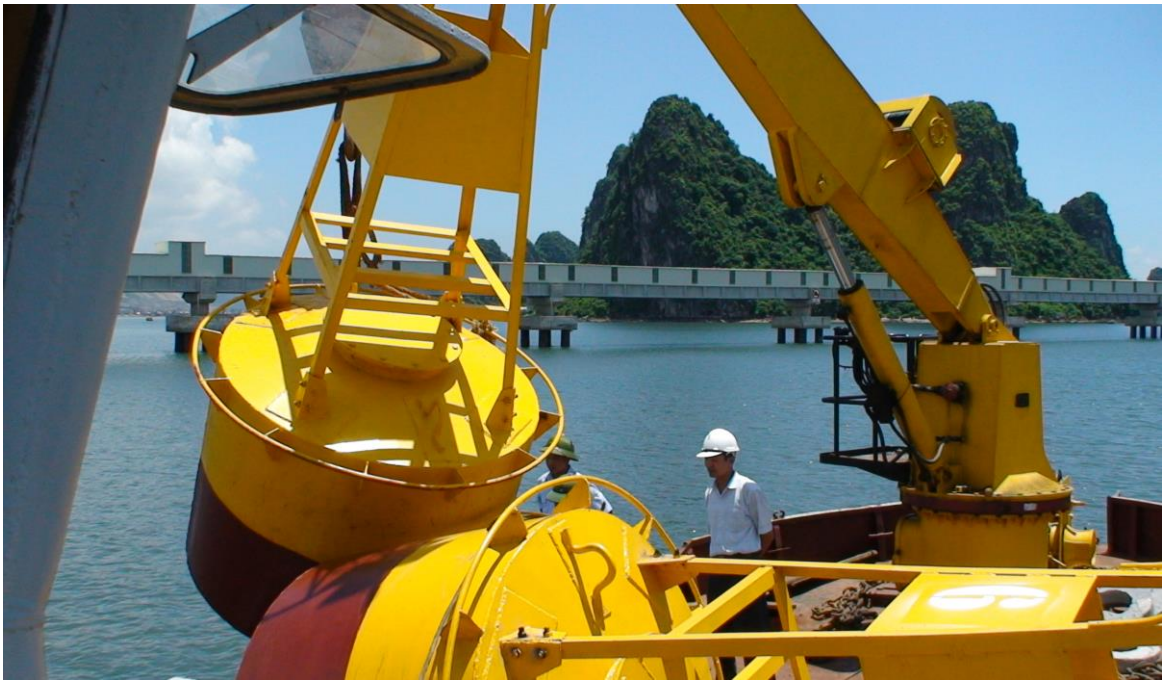
Công ty đang thực hiện lắp đặt hệ thống báo hiệu giới hạn vùng nước cho Cảng xuất Clinker thuộc nhà máy xi măng Cẩm Phả
