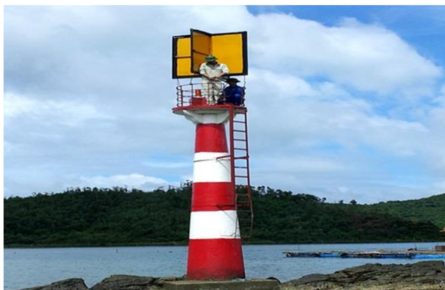
Công nhân của Công ty đang kiểm tra Cột báo hiệu số 03 luồng Vịnh Hạ Long
